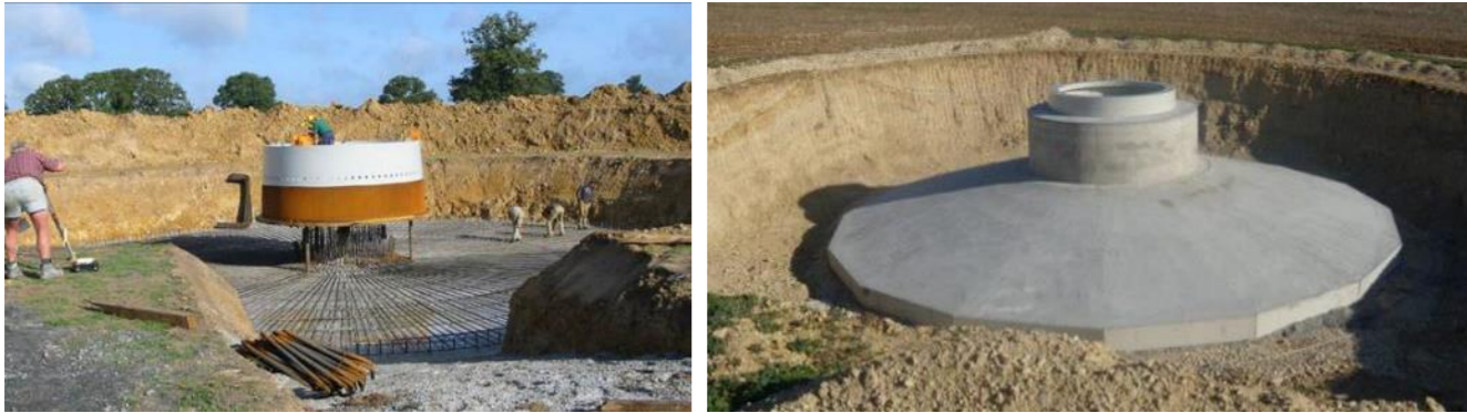
Figure 11 : Le ferrailage et le coulage d'une fondation d'éolienne
